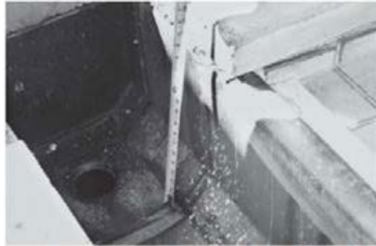
- Misurazione dell'altezza del vano di alloggiamento
