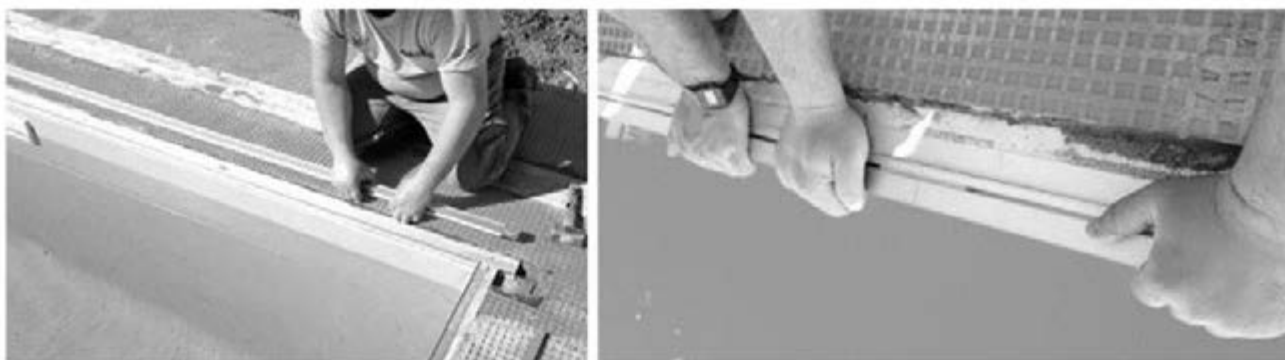
Figura 1: Inserimento dei binari nella guida sottobordo
