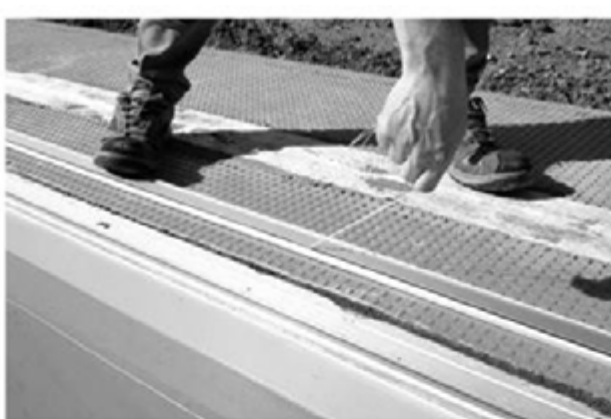
Figura 1: Inserimento fune lungo il binario
