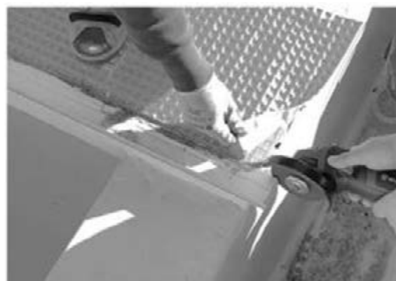
Taglio dell'ala laterale della guida nel punto di sbalzo
